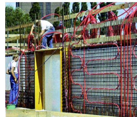
Abb. 26 (links): Leitungsführung, aktive Wärmedämmung Abb. 27 (oben): einschalige Außenwand Abb. 28 (rechts): einschalige Außenwand Abb. 29 (mitte): Technikintegration im Bauteilquerschnitt
