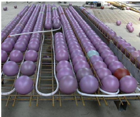
Abb. 30 (oben): BubbleDeck mit Bauteilaktivierung Abb. 31 (mitte): BubbleDeck Grundmodulherstellung Abb. 32 (unten): BubbleDeck Halbfertigteil Abb. 33 (unten mitte): BubbleDeck Halbfertig- und Fertigteil Abb. 34 (unten rechts): BubbleDeck Aufbau
